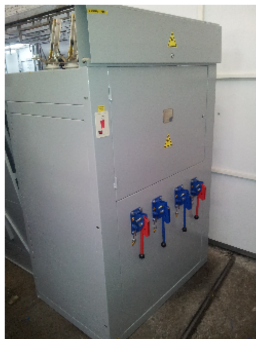
КСО-393 Секционная с верхним разъединителем
